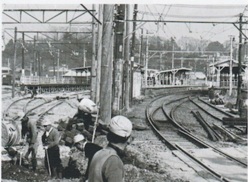
二子橋側から見た工事中の二子玉川園駅（右が高架にするために取り壊される大井町線のプラットホーム。左が玉電のホームを移設したあとに作られた大井町線用の仮プラットホーム。仮プラットホームあたりに右の写真のビルや2階建ての建物が建つ）（1965（昭和40）年2月）
