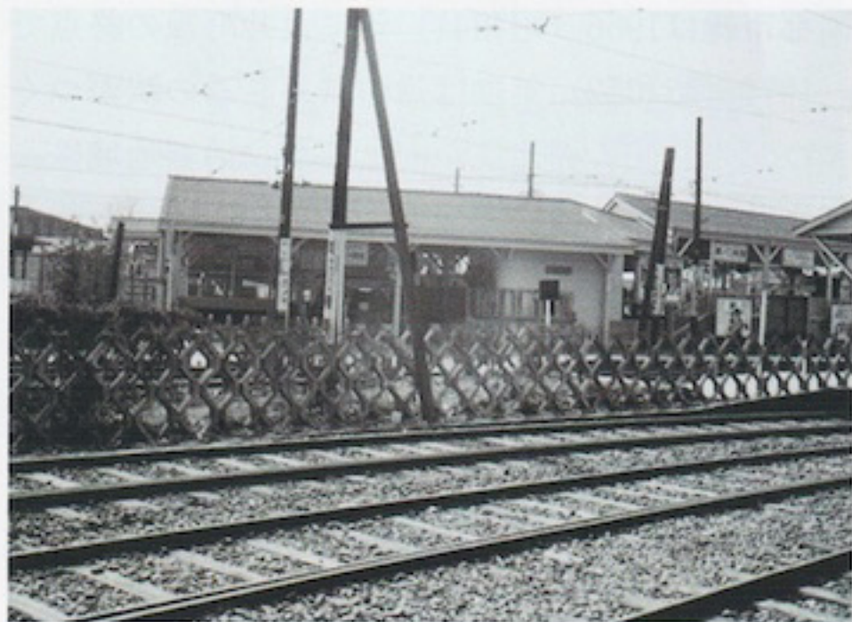
1962（昭和37）年2月の二子玉川園駅玉電乗換口駅舎（手前が玉電の線路、奥のホームが大井町線）
