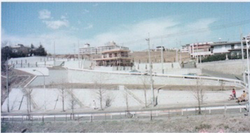
完成した造成地（1979年2月 宮前平駅付近）
