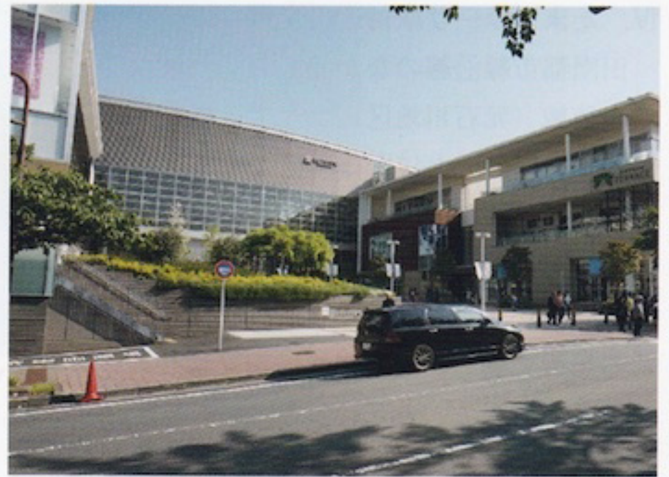
2014年のたまプラーザ駅前（奥の大きな建物が駅舎）
